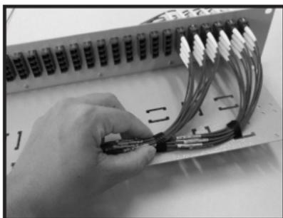
**9-** Para instalação de cordões no PAINEL Slim conecte nos adaptadores os cordões já conectorizados e divida em grupos para fixar os cordões na bandeja do PAINEL nos rasgos perfil C.
