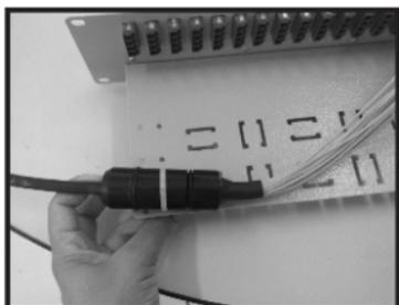
**2-** Fixe na bandeja a junção do Cabo Trunk com 2 abraçadeiras de nylon de 150mm no **Painel Slim**.
