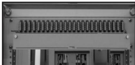
**8-** Instale o Painel Slim no Rack ou Bastidor e coloque o painel frontal cego para finalizar.
