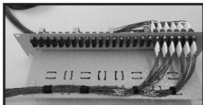
**10-** Após o processo de colocação dos cordões finalize com a organização dos cordões com Velcro.
