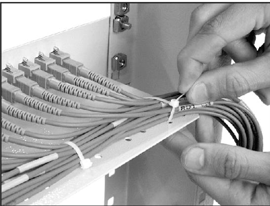
**2-** Conecte los cordones ópticos en la parte posterior del **Panel SLIM** y conduzca las fibras por la bandeja, fijándolas con las abrazaderas de nylon;
