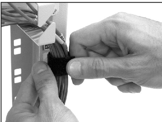
**4-** Agrupe las fibras con un velcro o abrazadera de nylon y conduzca su trayecto por las canaletas laterales del rack.
