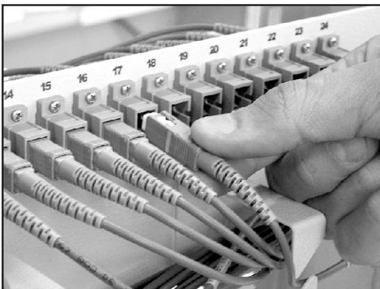
**3-** Conecte los cordones ópticos en la parte delantera del **Panel SLIM** y conduzca las fibras por las guías de cable;
