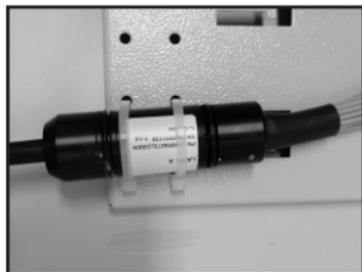
**2-** Fixe na bandeja do **Painel Slim144**, utilizando as abraçadeiras de Nylon de 150mm, a junção do Cabo Trunk.
