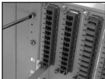
**1-** Encaixe as porcas gaiola no plano frontal de fixação do Rack e com uma chave Phillips fixe o **Painel Slim144** usando os parafusos e arruelas lisas M5 presentes no kit de fixação.
