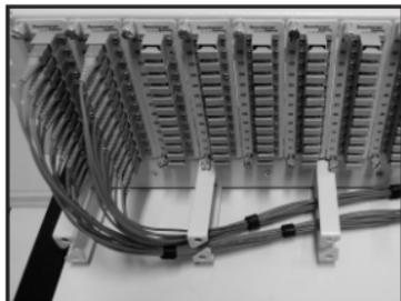
**7-** Organice la salida de las fibras en guía del cable frontal, utilizando el Velcro doble cara, finalizando así su instalación.
