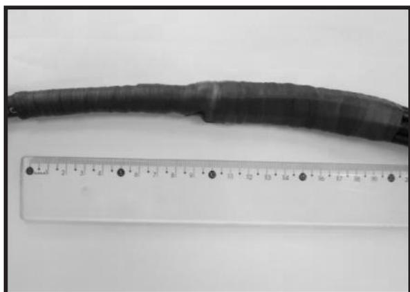
13. Corte 90 cm de cinta auto fusión y proteja el área de encuentro de la chaqueta del cable con los tubos de protección flexibles. Después de aplicada la cinta, debe estar con 10 cm en cada lado. Repita las operaciones de los artículos 6 a 11 para el otro lado del QDF-610;
