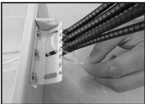
9. Después de instalar los pares, fije todo el conjunto de tubos de protección flexibles al soporte de entrada del cable con 2 abrazaderas de 150 mm;
