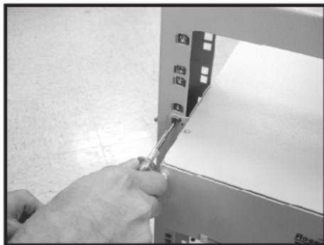
1- Encaixe as porcas-gaiola no plano frontal de fixação do bastidor; com os parafusos e aruelas lisas M5, fixe o **DIO OFFICE DOUBLE ESPELHAMENTO**;
