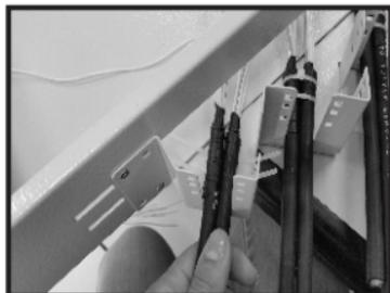
5- Introduza os tubos loose pela entrada de cabos traseira do **DIO**; fixando os cabos no suporte com abraçadeiras 150mm. (conforme foto);
