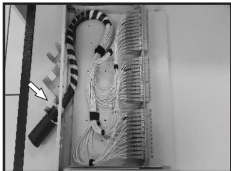
6- Utilizando abraçadeiras nylon 150mm fixe a junção no suporte na traseira do **DIO OFFICE DOUBLE ESPELHAMENTO** conforme indicação na figura ao lado.
