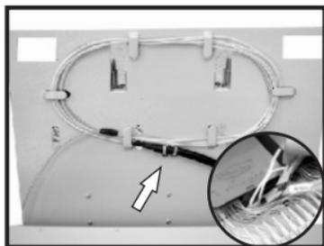
8- Na parte **Inferior** da bandeja, fixe a ponta do tubo espiral no local indicado, utilizando 02 abraçadeiras de nylon 150mm. Acomode os tubos loose nos clips de acomodação;
