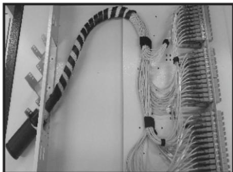
5- Para instalar cabo Trunk, plugue os conectores nos adaptadores conforme a identificação das vias nas portas referente. Com um pedaço de 70mm de velcro junte as fibras e organize (conforme imagem). Antes de chegar no final da bandeja, insira o espiral para proteger as vias;
