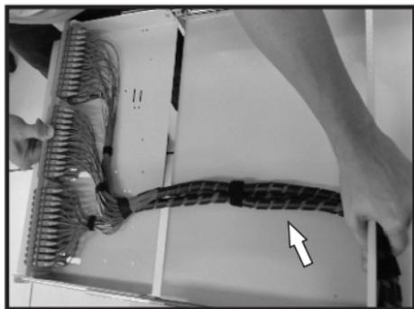
4- Fixe no rasgo da traseira do **DIO OFFICE DOUBLE ESPELHAMENTO**, fixe com velcro as fibras já protegidas com espiral, para manter os grupos organizados uma os espirais com o velcro;
