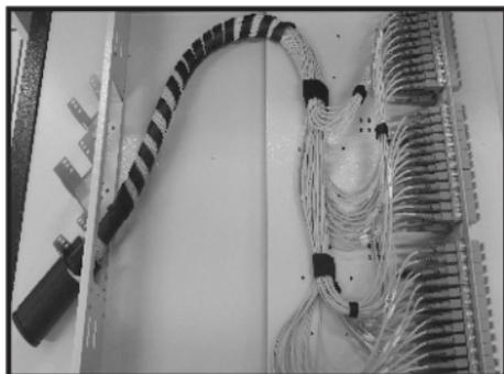
5- Para instalar el cable Trunk, enchufe los conectores en los adaptadores según la identificación de las rutas en las puertas referencia. Con 70mm de velcro reúna las fibras y organícelas (como en la imagen). Antes de llegar al final de la bandeja, inserte el espiral para proteger las rutas;
