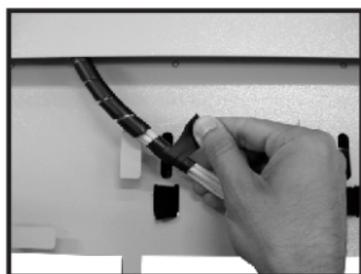
**7-** Encaje la bandeja de empalme del DIO; envuelva una cinta de auto fusión en los tubos Loose en la extremidad del tubo espiral;
