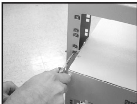
**1-** Encaje las tuercas-jaula en el plan frontal de fijación del bastidor; y con los tornillos y arandelas lisas M5 fije el **DIO OFFICE DOUBLE ESPEJADO**;
