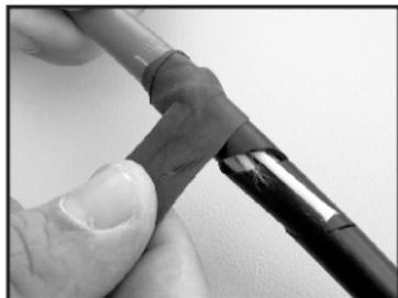
**5-** Decape o cabo óptico e insira os tubos loose no tubo espiral, deixando para fora o elemento de tração; una o tubo espiral ao cabo óptico com um pedaço de fita de auto fusão; com um alicate, apare o elemento de tração deixando 2cm;
