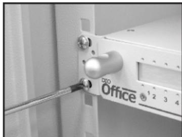
**1-** Encaixe as porcas-gaiola no plano frontal de fixação do bastidor e, com uma chave Philips, fixe o **DIO Office** usando os parafusos e arruelas lisas M5 presentes no kit de fixação;
