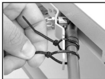
**7-** Prenda a ponta do elemento de tração no Clip do suporte traseiro; fixe o cabo óptico neste suporte com as abraçadeiras de nylon de 15cm; com um alicate, apare as sobras das abraçadeiras;
