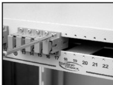
**2-** Remova a tampa-cega e fixe os adaptadores. A furação do painel já possui rosca (M2), dispensando aqui o uso de porcas;
