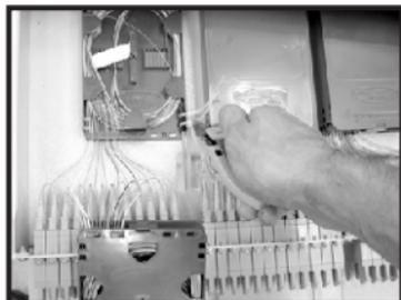
9- Retire a trava do cassette para articulá-lo; passe os tubos loose para a parte superior da bandeja através dos furos oblongos e encaminhe-os para o cassette de emenda; passe um pedaço de fita auto fusão sobre o tubo loose na entrada do cassette.
