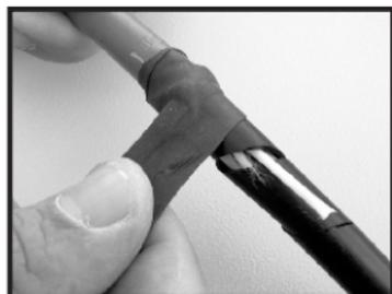
**4-** Decape el cable óptico e inserte los tubos loose en el espiral, proteja con la cinta de auto fusión el área de unión entre el cable y la extremidad del tubo espiral y el área entre la otra extremidad del espiral y el tubo loose.
