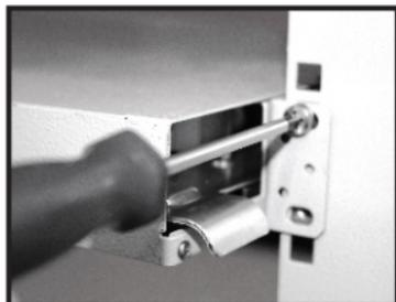
**1-** Encaje las tuercas-jaula en el plan frontal de fijación del bastidor; y con los tornillos y arandelas lisas M5 fije el **DIO INTERCON II ESPEJADO**.
