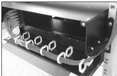
7- Retorne os painéis / módulos no **DIO HDS4**, faça as conectorizações frontais e utilizando os acomodadores plástico, agrupe as fibras conduzindo o feixe de cordões pelas aberturas frontais.
