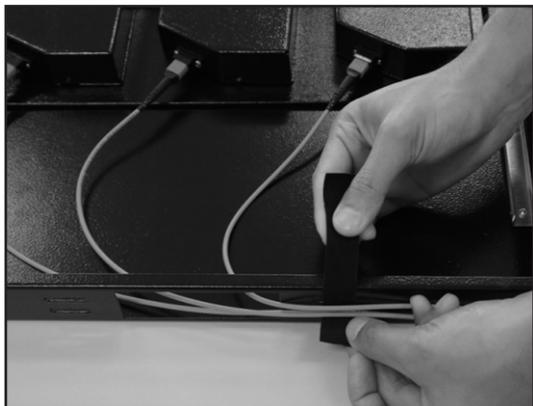
**4-** Para entrada de cabos traseiro, agrupe os cordões e fixe-os com Velcro dupla face no chassi e encaminhe para o interior do **DIO HDS-1**.
