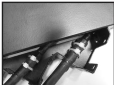
5- Encaixe os cabos no suporte inclinado traseiro do DIO e fixe-os, utilizando as abraçadeiras 150mm;
