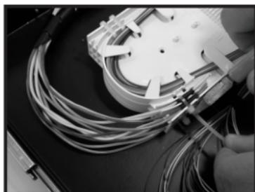
8- Proteja o tubo Loose com a fita de auto fusão. Utilizando duas abraçadeiras de 100mm, fixe o tubo Loose, **pela parte protegida**, no cassette de emenda (apare as sobras das abraçadeiras);
