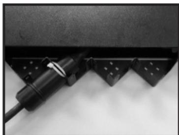
6- Utilizando as abraçadeiras de nylon de 150mm fixe a junção ou o cabo break out no suporte inclinado traseiro;
