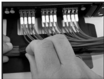
**10-** Faça as conectorizações frontais, conduza o feixe de cordões ópticos pelas aberturas laterais da bandeja e fixe o feixe com uma tira de velcro. Feche o **DIO EC072** finalizando sua instalação.
