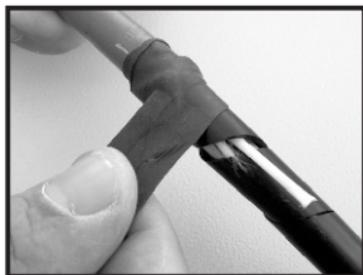
**4-** Decape o cabo óptico e proteja com a fita de auto fusão a área entre o cabo e os tubos Loose;
