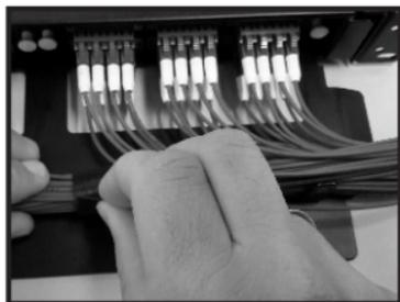
8- Faça as conectorizações frontais, conduza o feixe de cordões ópticos pelas aberturas laterais da bandeja e fixe o feixe com uma tira de velcro. Feche o **DIO EC072** finalizando sua instalação.
