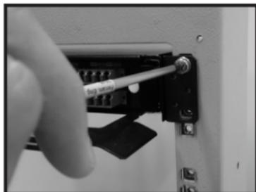
1- Encaje las tuercas jaula en el plan frontal de fijación del bastidor; y con un destornillador Philips fije el **DIO EC072** utilizando los tornillos y arandelas planas M5 incluidos en el kit de fijación;
