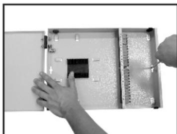
**3** - Fixe o **DGO P-24** utilizando as buchas, parafusos auto-atarraxantes e arruelas presentes no kit; o **DGO P-24** pode ser fixado de modo que a tampa abra para a direita ou esquerda;
