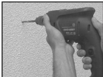
**2** - Faça a marcação dos furos na parede utilizando o próprio chassis do **DGO P-24** como gabarito; utilize uma broca de 6mm na furadeira;
