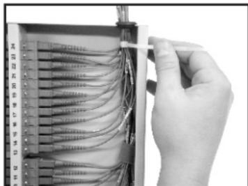
**10 -** Com um estilete, faça um corte em "X" na outra tampa de borracha; passe os cordões um por um pela abertura feita na tampa de borracha; agrupe-os, na saída, com as abraçadeiras de nylon de 10mm, travando-os no suporte do chassis;
