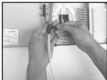
**6-** Enrole um pedaço de fita de auto-fusão no decape do cabo óptico;
