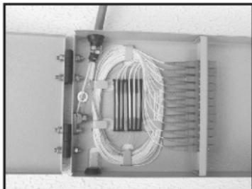
**9-** Acomode as fibras no **DIO** e apare as sobras, alinhando-as ao centro do berço de emendas; desenrole as fibras e faça as fusões; retorne as fibras já fundidas, inserindo os protetores de emenda no berço;
