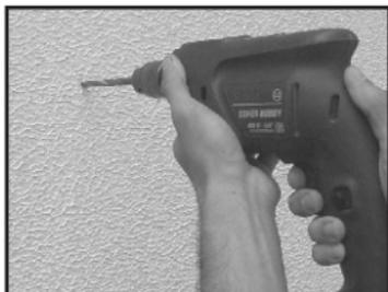
**2-** Faça a marcação dos furos na parede utilizando o próprio chassi do **DKO P-12** como gabarito; utilize uma broca 6mm na furadeira;
