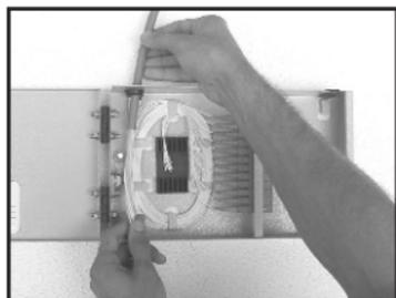
**5-** Com um estilete, faça um corte em forma de "X" no centro da tampa de borracha; decape 2 metros do cabo óptico; insira o cabo pelo tampão;
