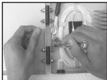
**7-** Decape o tube loose; corte o elemento de tração, deixando uma sobra de aproximadamente 4cm e prenda essa sobra no terminal de tração; utilize uma chave de boca de 10mm.
