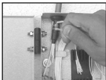
**8-** Com 2 abraçadeiras de nylon de 10cm, fixe o cabo óptico à haste do chassi; com um alicate, corte as sobras das abraçadeiras;
