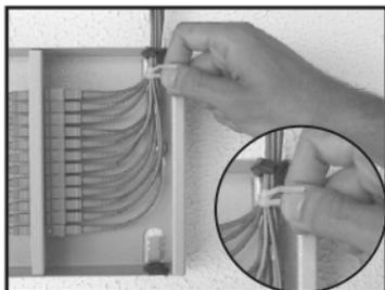
**10-** Com um estilete, faça um corte em na outra tampa de borracha, por onde sairão os cordões; insira os conectores nos adaptadores; passe os cordões pelo corte da tampa; agrupe-os, na saída, com as abraçadeiras de nylon de 10cm;
