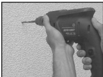
**2-** Haga el marcado de los orificios en la pared usando el chasis del **DGO P-12** como guía; utilice una broca de 6mm en el talandro;
