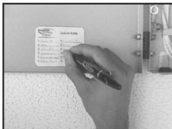
**11-** Haga el resgistro de las rutas de las fibras en la etiuqeta pegada en la parte interna de la tapa dela **DGO P-12**;
