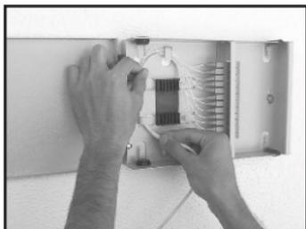
**4-** Inserte los pigtails en los adaptadores y enrútelos a la base de empalme, envolviéndolos en las guías impresas;
