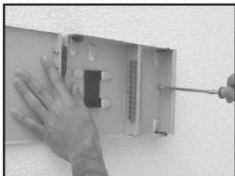
**3-** Fije el **DGO P-12** utilizando los bujes, tornillos auto blocantes y arandelas incluidas en el kit; se puede fijar el **DGO P-12** para que la tapa se abra hacia la derecha o izquierda;
