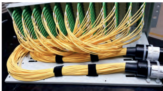
Instalação de cabos - Trunk
