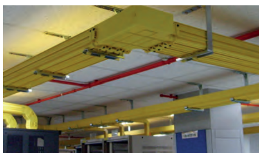
Instalação de infraestrutura, esteiramento - calhas Raceway
