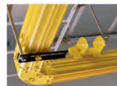
Instalação de infraestrutura, esteiramento - calhas Raceway
