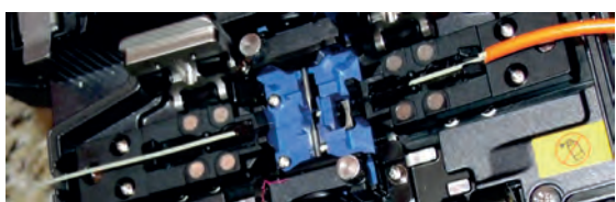
Serviço de fusão de fibra óptica
