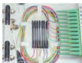
Alojamiento de los pigtails de fusión
