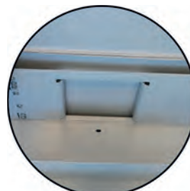
Umbral para el paso de patchcords espalda a espalda
