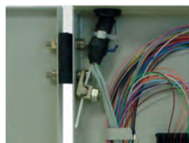
Sistema de bloqueo del elemento de tracción del cable óptico
