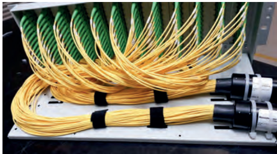
Instalación de cables - Trunk
