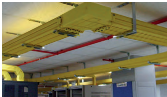
Instalación de infraestructura, ductería - Canaletas Raceway
